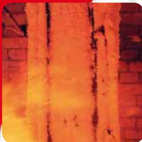
Trave in acciaio protetta dalla vernice intumescente
